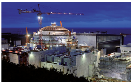
Chantier du réacteur de Flamanville en 2015 © EDF
